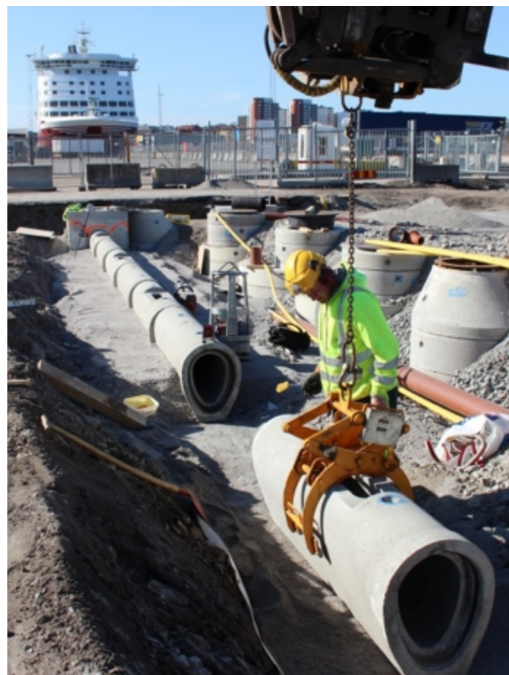
Stockholms hamnar. Byggnad av dagvattenrännna, vartannat rör med rännna.
