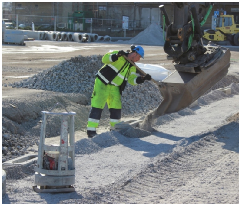
Stockholms hamnar. Kringfyllning av ledning och understoppning av betäckning.
