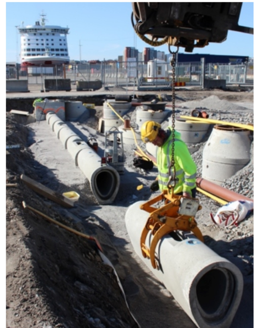
Stockholms hamnar. Byggande av dagvattenränna, vartannat rör med ränna.
